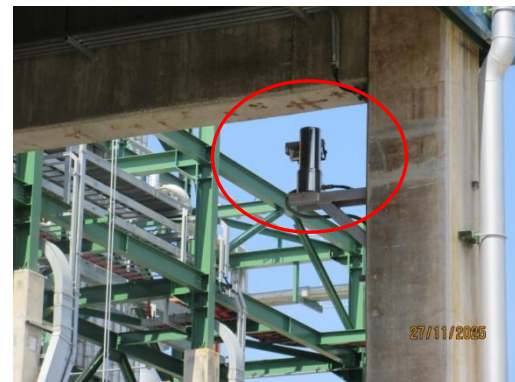
รูปที่ 3-58 การติดตั้ง CCTV ในพื้นที่โรงโอเลฟินส์
