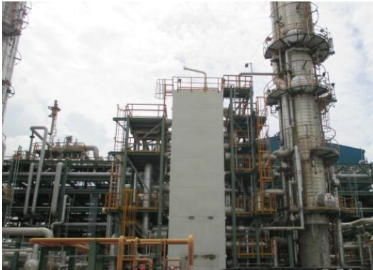
รูปที่ 3-50 Concrete Fireproofing
