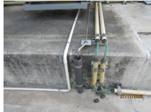
รูปที่ 3-51 ระบบ Grounding
