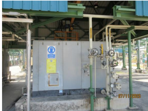
รูปที่ 3-34 ฝารอบเครื่องจักรเพื่อลดระดับเสียงจากแหล่งกำเนิด
