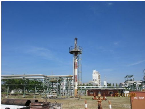
รูปที่ 3-4 Low Pressure Flare
