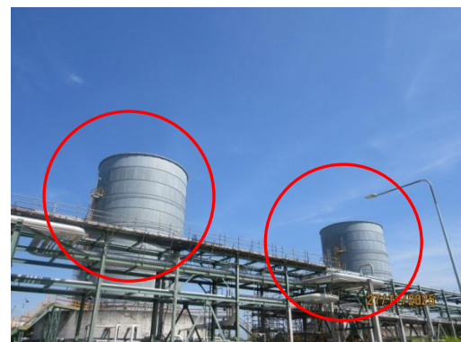
รูปที่ 3-5 หอเผาชนิด Enclosure Ground Flare (EGF)
