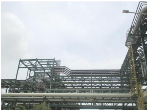
รูปที่ 3-63 ติดตั้งท่อรับวัตถุดิบก๊าซหนัก (Heavy Gas) จากโรงอะโรมาติกส์และโรงกลั่นน้ำมัน
