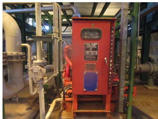
เครื่องสูบน้ำดับเพลิงด้วยเครื่องยนต์ดีเซล
