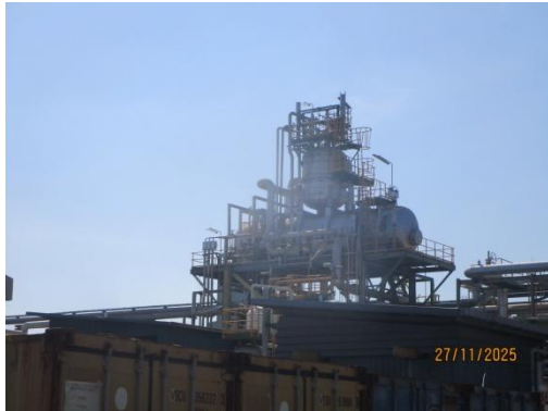
รูปที่ 3-21 Deaerator สำหรับผลิตน้ำ ป้อนหม้อไอน้ำ
