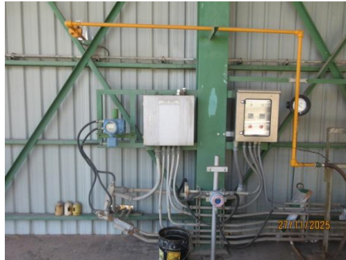
รูปที่ 3-65 Chlorine Gas Detector
