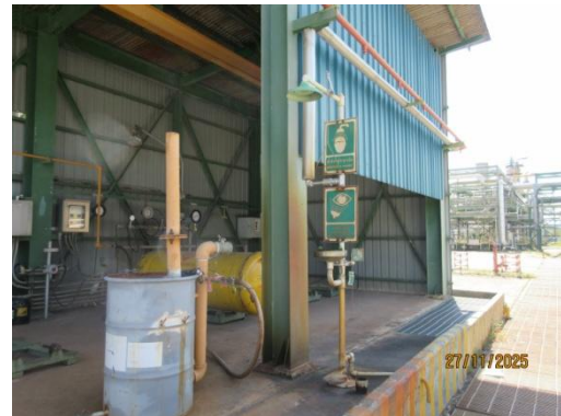
รูปที่ 3-40 ฝักบัวฉุกเฉินและที่ล้างตา (Safety Shower)
