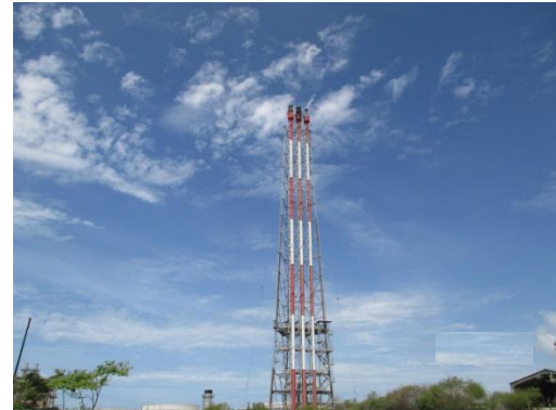
รูปที่ 3-7 หอเผาชนิด Elevated Flare (EF) ของโรงผลิตสารโอเลฟินส์ โรงที่ 1/2
